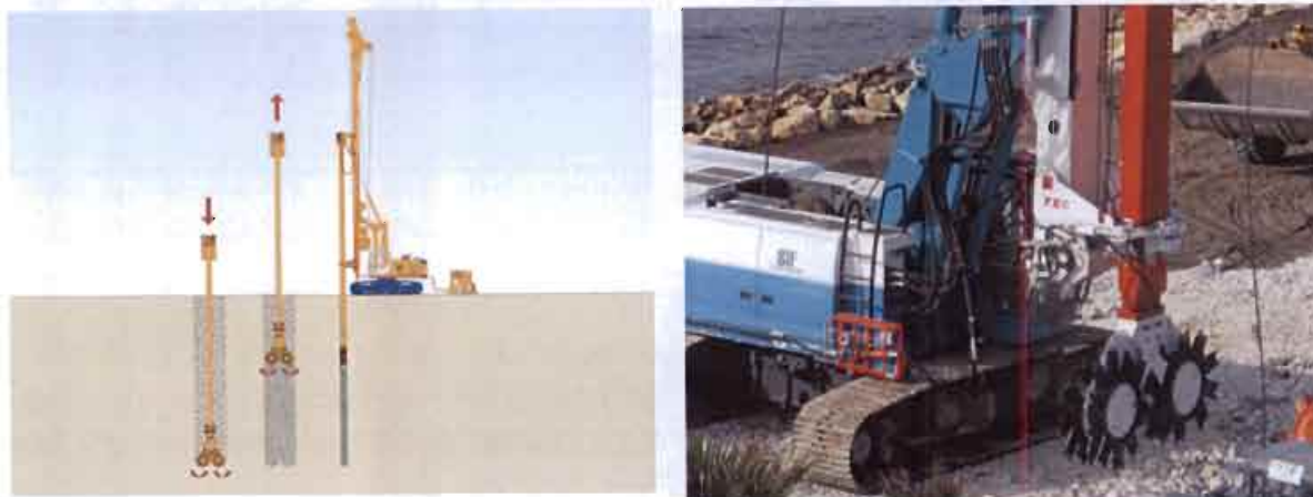
Figura 9: Tecnologia CSM - fasi di esecuzione.
