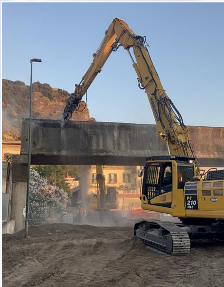
Attività di demolizione scatolare
