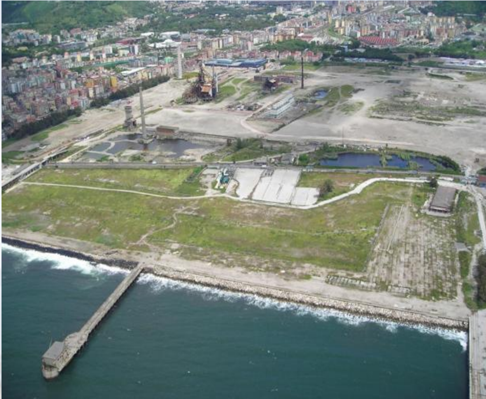
Caratterizzazione integrativa Colmata e Arenili
