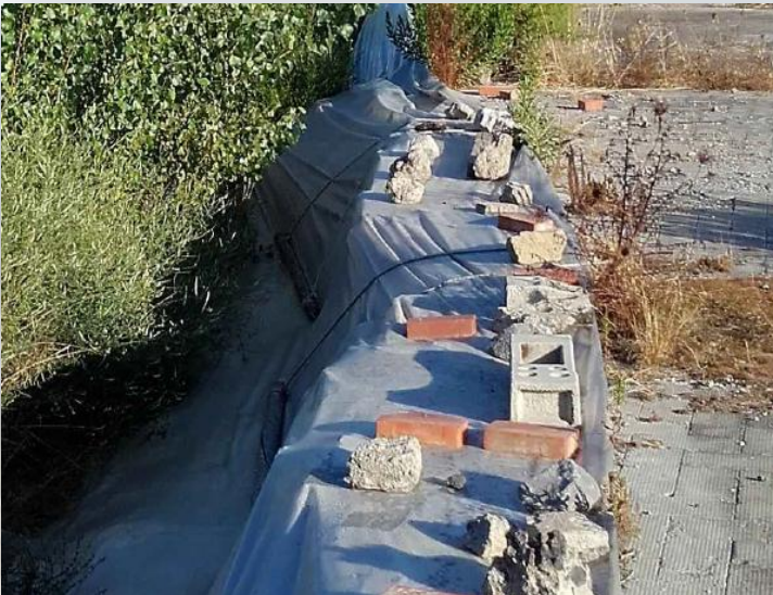
Manutenzione fronti di scavo
