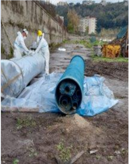
Rimozione sottoservizi in MCA
