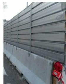
In fase di cantiere, l'attuale muro di confine verso la ex caserma Battisti sarà sostituito da una recinzione in new jersey e lamiera grecata dell'altezza complessiva di quattro metri. Durante la sola fase di realizzazione delle opere di sostegno, la carreggiata, in corrispondenza di questo tratto, sarà ridotta a una sola corsia. Sarà comunque garantita la percorrenza degli autobus.
