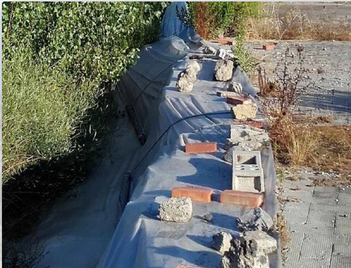
Manutenzione fronti di scavo
