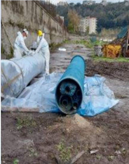
Rimozione sottoservizi in MCA
