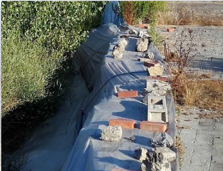
Manutenzione fronti di scavo
