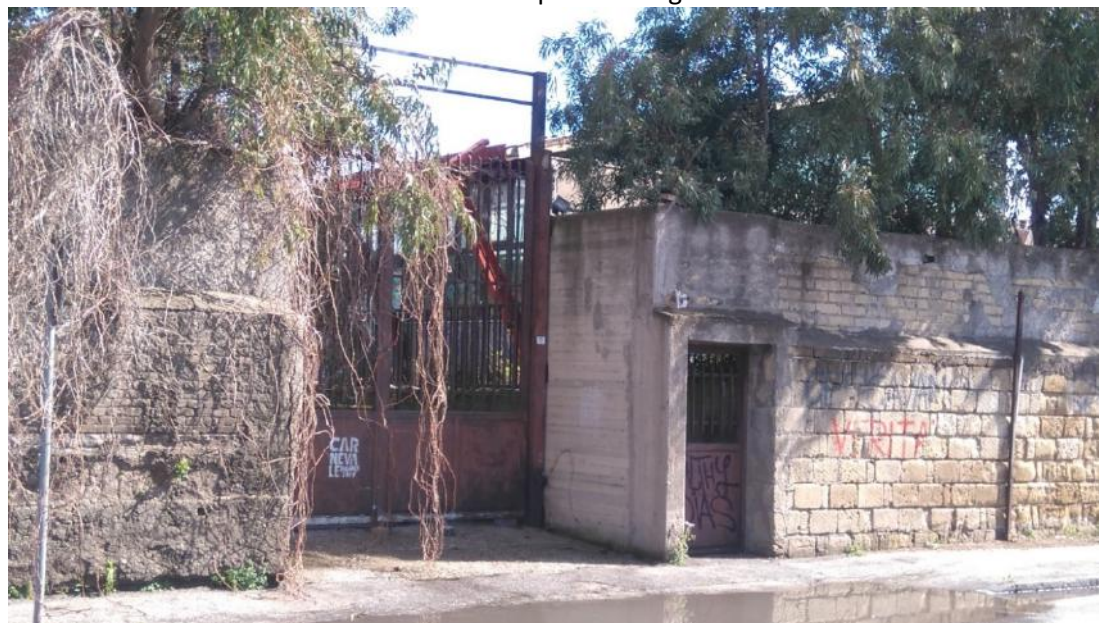
Ingresso da Via Coroglio
