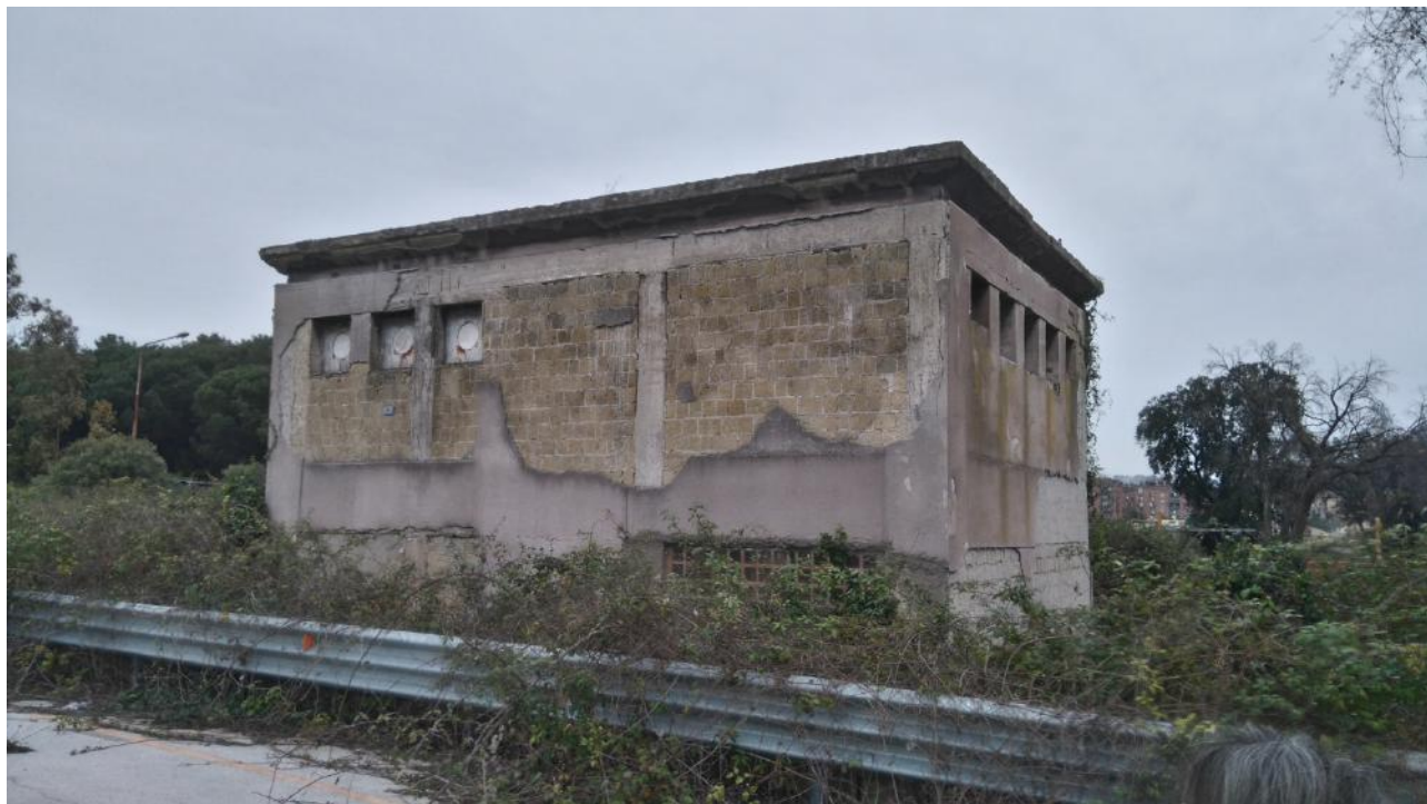
Vista da Via Cocchia
