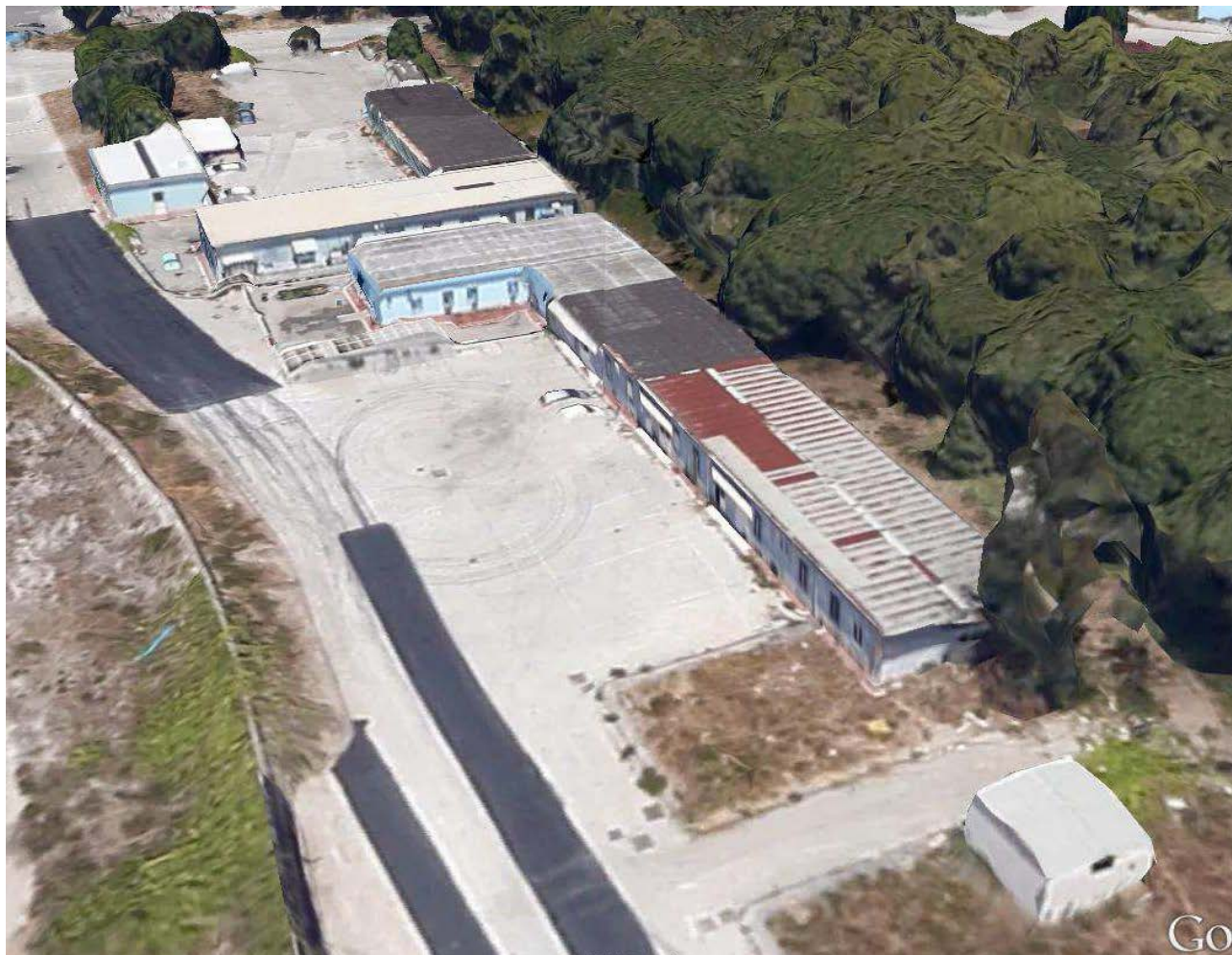
Vista da Via Cocchia
