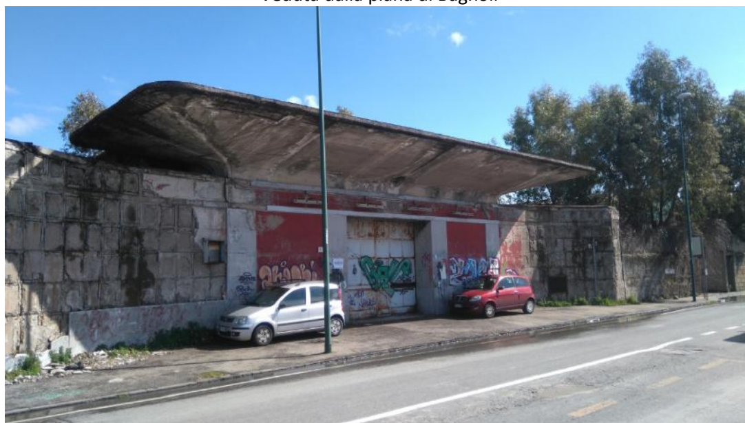
Ingresso da Via Coroglio
