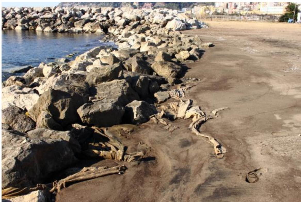
Particolare degli ancoraggi del telo TNT
